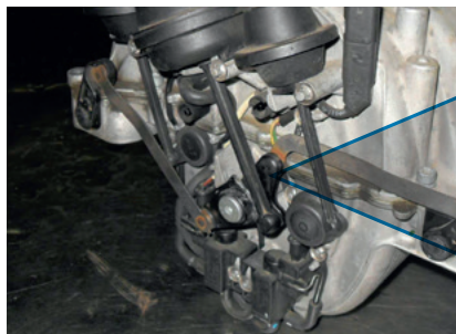
Kárhelyzet: A kapcsolórudazat törése
