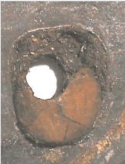
Detailansicht eines zerstörten Wasserdurchganges
