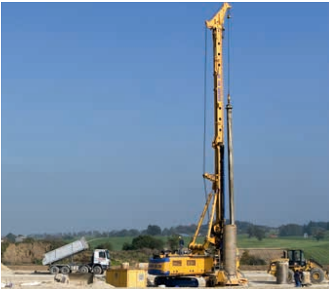
Machine de battage et de forage
