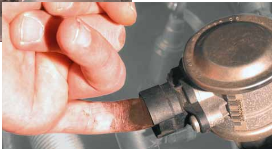
Controllo rapido sulla valvola dell'aria secondaria in una vettura BMW 520i (evidenziata)
