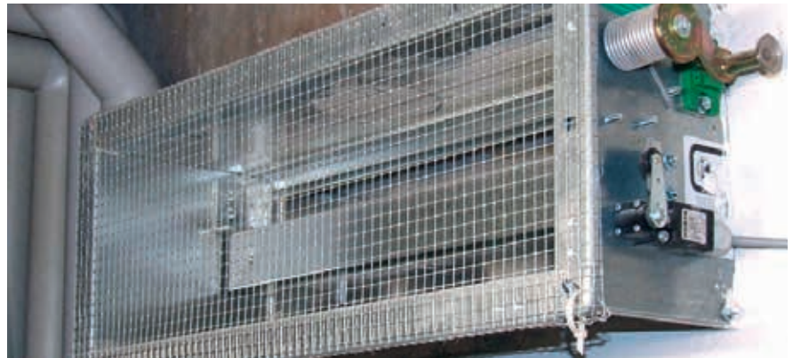
Compuerta cortafuegos
