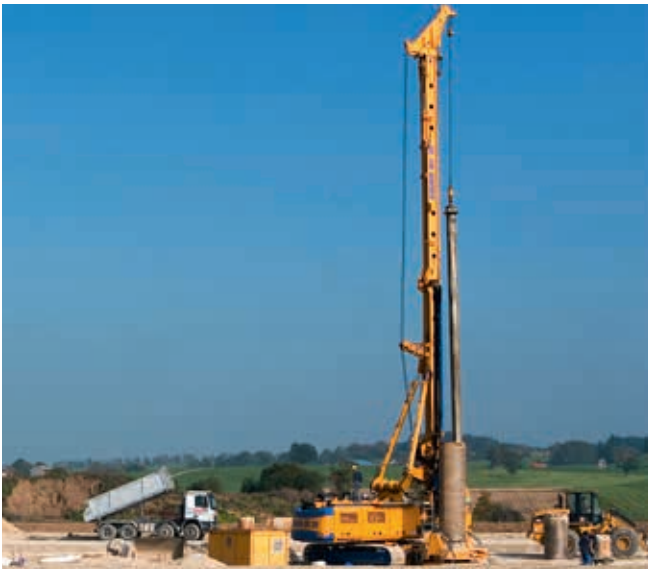
Ramm- und Bohrmaschine
