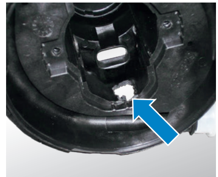
损坏图：外壳熔痕（从上方查看外壳内部）
