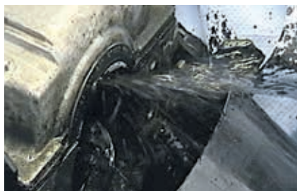
Внимание! При безупречном снабжении смазочным маслом отсюда могут вытекать 30–60 литров в час.
