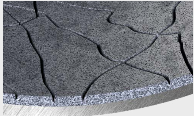
Fig. 2: Red de grietas
